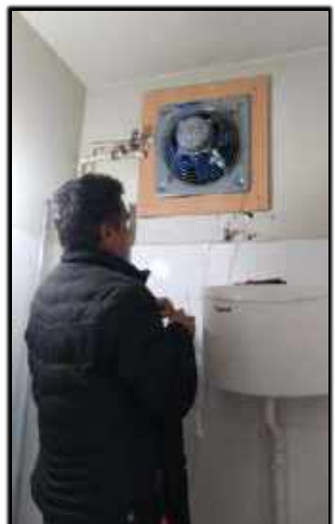
✓ رفع قطعی برق هواکش دستشویی ساختمان آموزش
