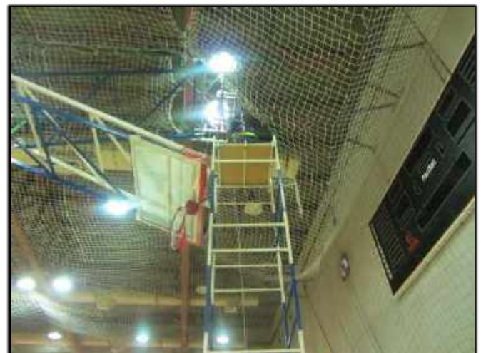
✓ تعمیر و نصب موتور بالابر تورهای بسکتبال
