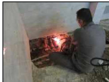
✓ ساخت و نصب حفاظ خوابگاه
