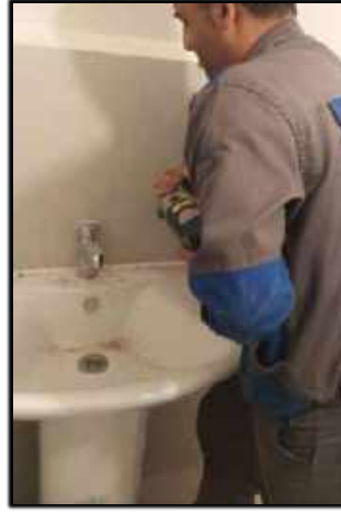
✓ نصب جا مایع و شیر مخلوط آشپزخانه
