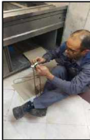
✓ تعویض المنت گرمکن آشپزخانه ساختمان اداری
