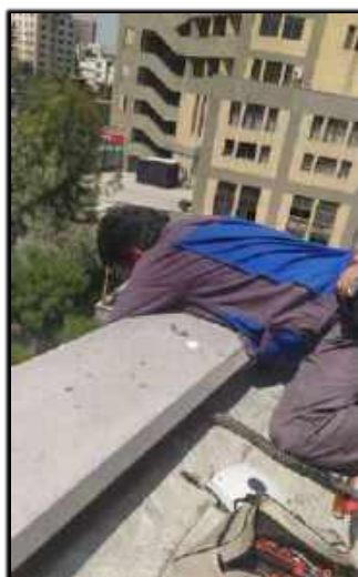
✓ جابجایی و نصب دوربین مدار بسته - جابجایی دوربین پشت بام و نصب مجدد آن
