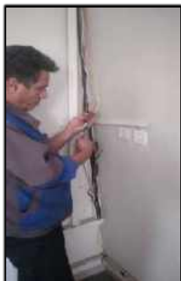
✓ داکت کشی و تعویض سیم های سوخته ریاست
