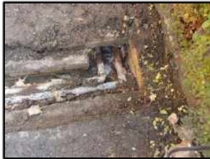
✓ کنده کاری، اصلاح و تعویض لوله کشی شوفاژ اتاق های تمرین خوابگاه
