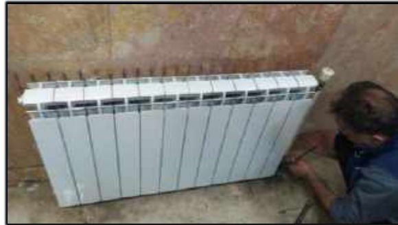
✓ نصب و مونتاژ رادیاتور های بخش اداری - تعویض لوله رادیاتور
